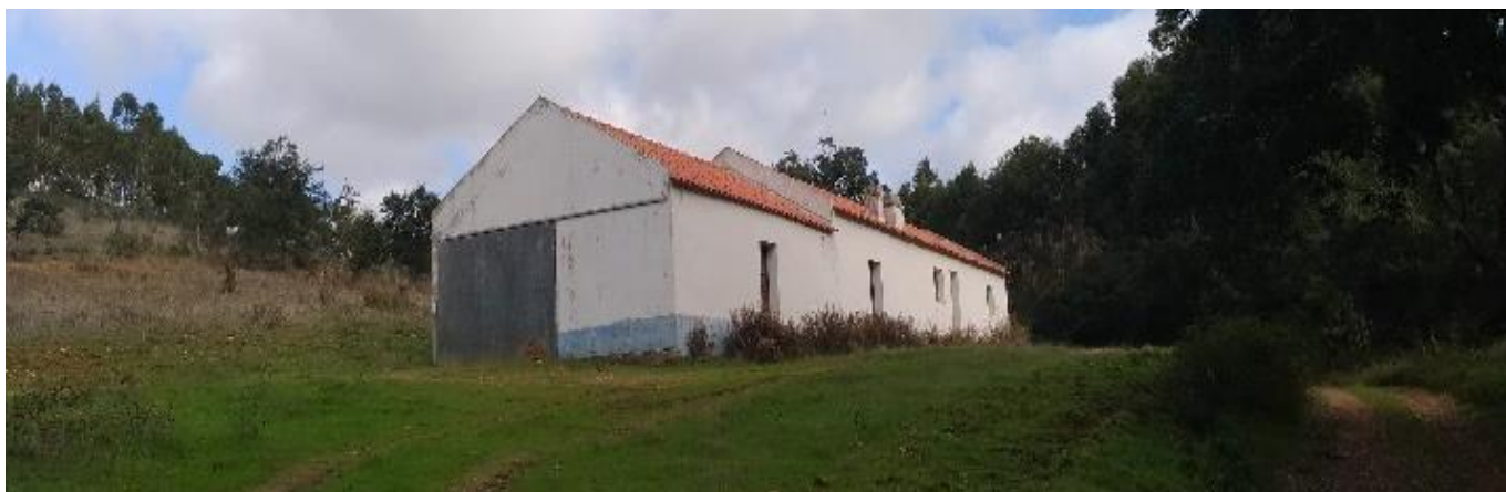
Figura 4.35 – Foto 5: Habitação localizada no corredor de Linha Elétrica aérea de média tensão
