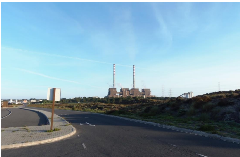
Figura 4.55 – Central termoelétrica de Sines (e rede de condutores associados)
