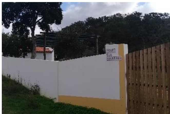
Figura 4.34 – Foto 4: Habitação localizada no corredor de Linha Elétrica aérea de média tensão
